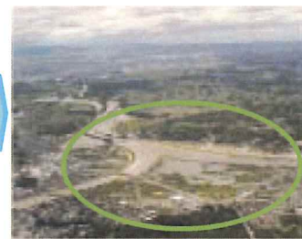
築堤後：台風6号洪水
