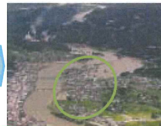
築堤後：台風6号洪水
