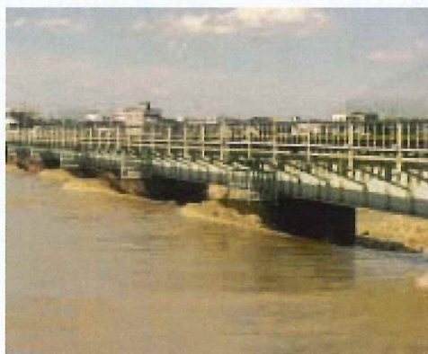
JR水郡線那珂川橋梁
