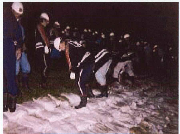
張り土のう工（東北）
