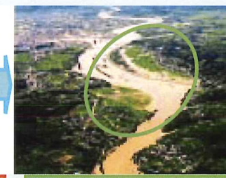
築堤後：台風6号洪水
