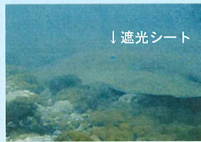
図4 遮光シートの設置状況
