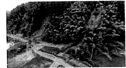
豪雨により土砂崩れが発生した大肥川流域（2017年7月8日、福岡県朝倉郡東峰村）
