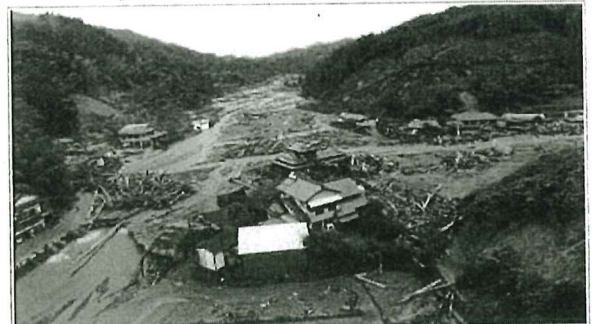
赤谷川が氾濫し流木と泥に埋もれた福岡県朝倉市（2017年7月7日）
