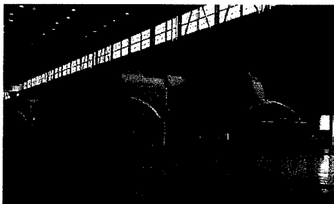
運転中の3号タービン発電機
