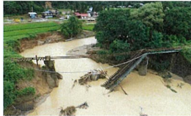
崩落したJR米坂線の鉄橋。早期復旧に向け、地方連絡調整会議を設置して関係機関が連携を確認した＝8月4日、飯豊町（ドローン使用）
