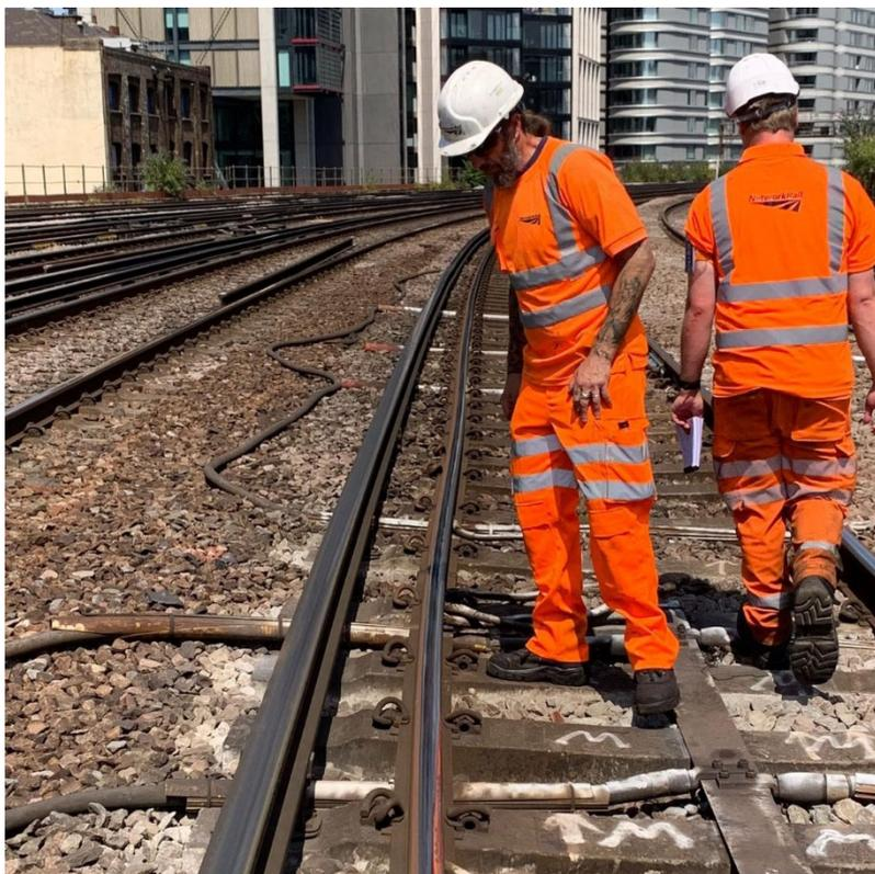
図2 ボクスホールにて歪んだ路線を点検する作業員（甲272）<sup>13</sup>
