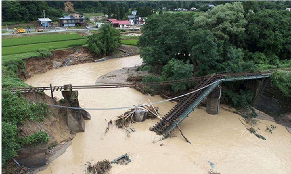
図14 崩落した米坂線橋梁（山形県飯豊町）<sup>59</sup>（甲303）
